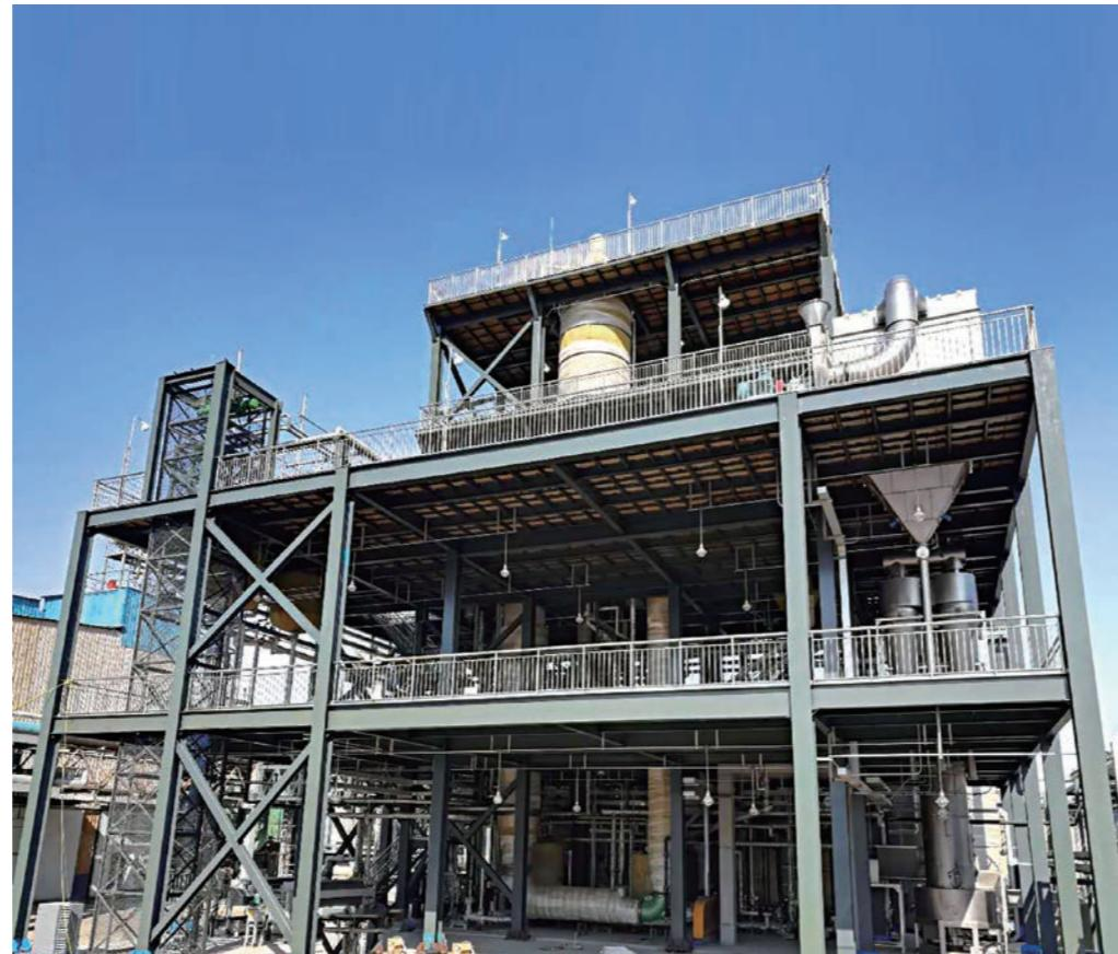
▲ 硫酸钠废水蒸发结晶系统
